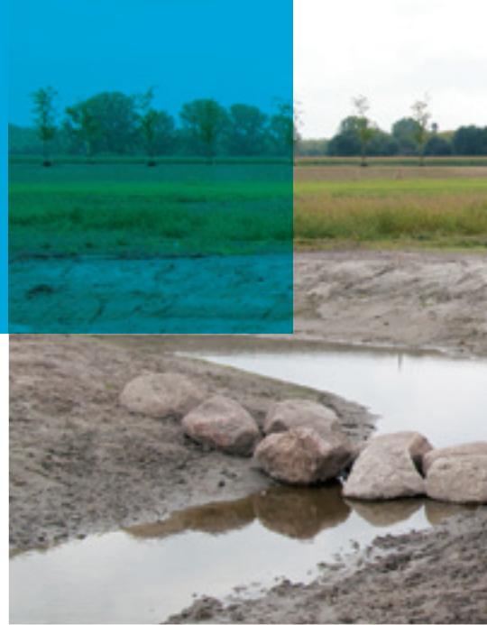
Aanleg nieuw park in Deventer
